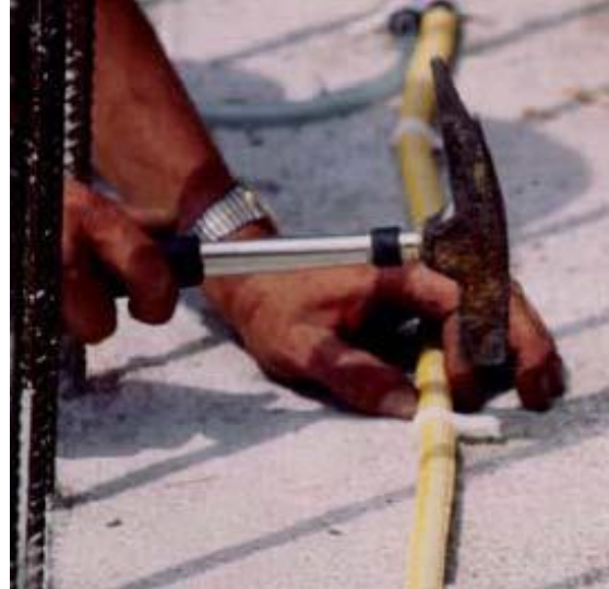
12. Метод перекрытия концов
