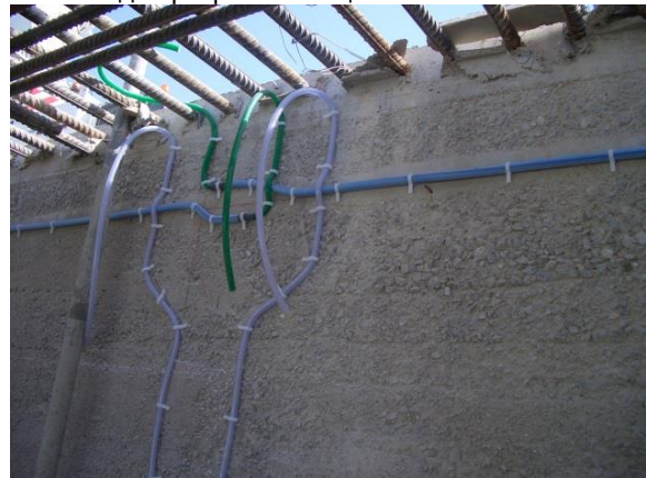
13. Установка системы на прямом отрезке
