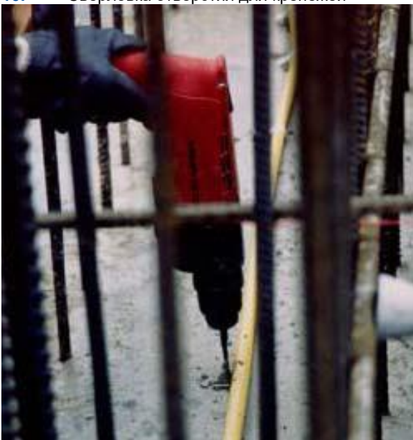
10. Сверловка отверстия для крепежей
