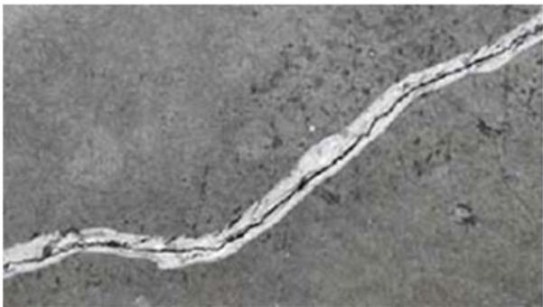
Рисунок 3. V-образная канавка вдоль трещины
