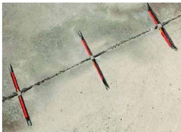
Рисунок 4. Установка стяжек в каналы, открытые в трещинах
