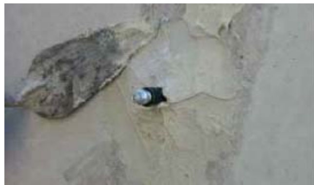
Рисунок 2. Герметизация пакера, установленного на поверхности и трещины при использовании соответствующего состава MasterFlow®.
